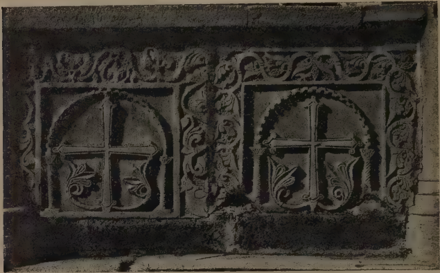
Fig. 215. — Parapet de la phiale de Lavra (Coll. Hautes Études, C. 145).
